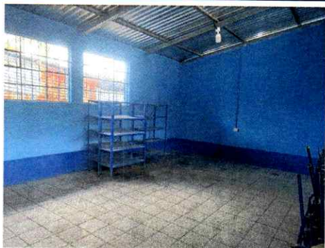
Foto 9: Módulos de aulas con piso de granito
