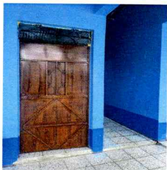
Foto 3: Puerta reparada e instalada.
