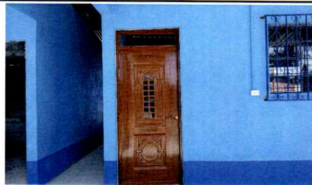
Foto 14: Puertas nuevas instalada en aula 2.
