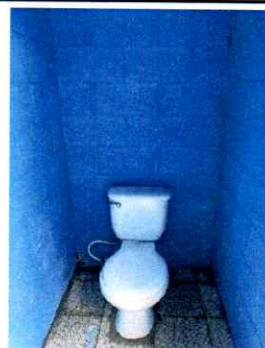
Foto 6: Inodoro nuevo instalado.
