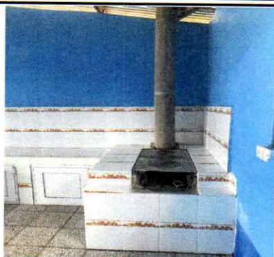
Foto 1: Plancha nueva instalada.
