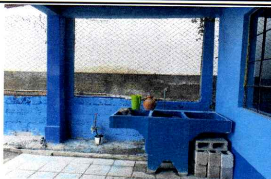
Foto 2: Pila nueva instalada
