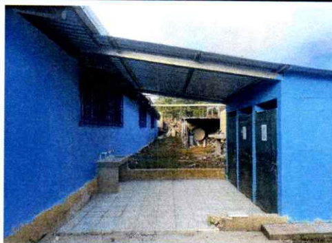
Foto 5: Piso de granito en módulo de baños.
