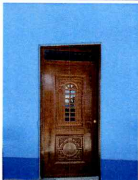
Foto 13: Puertas nuevas instalada en aula 1.
