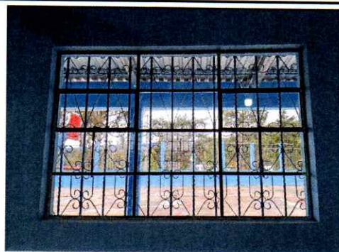
Foto 8: vidrios nuevos instalados en ventanas de módulo de aulas.
