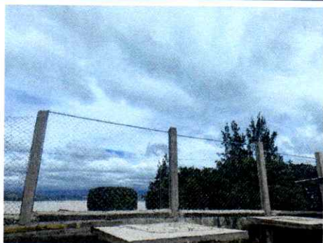
Foto 11: Muro perimetral finalizado, con columnas construidas e instalación de malla nueva.
