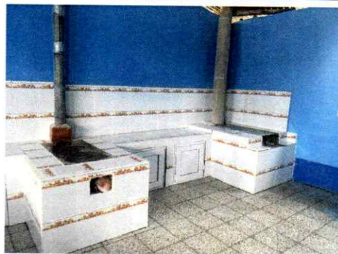
Foto 4: módulo de cocina con piso de granito.
